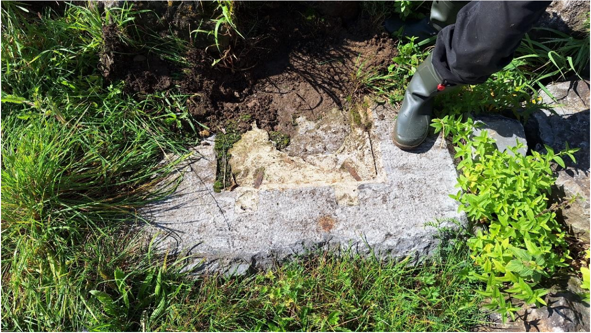
Detailoverzicht van steen met specie, dookgaten en ijzeren krammen.
