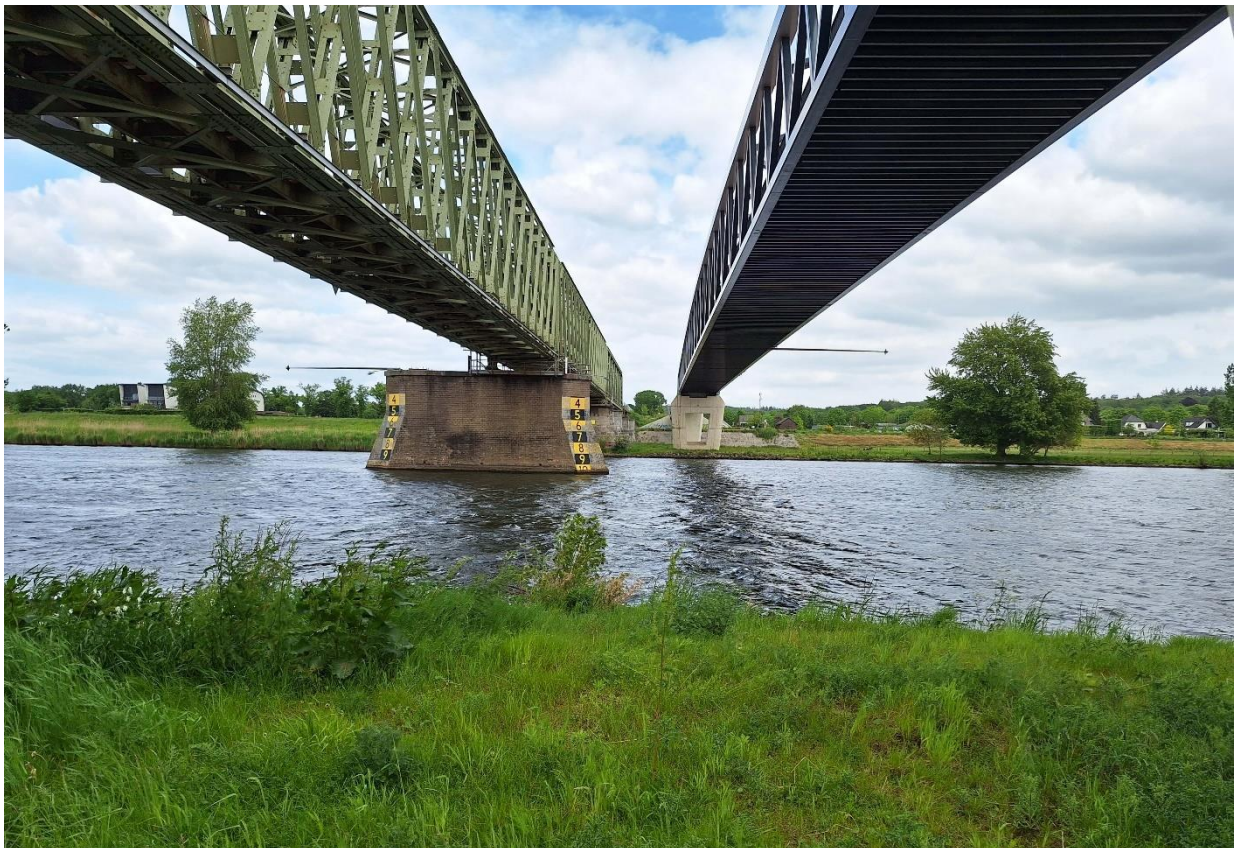
Afbeelding 1 De spoorbrug en fietsbrug bij Mook (Foto: Joost van den Besselaar).
