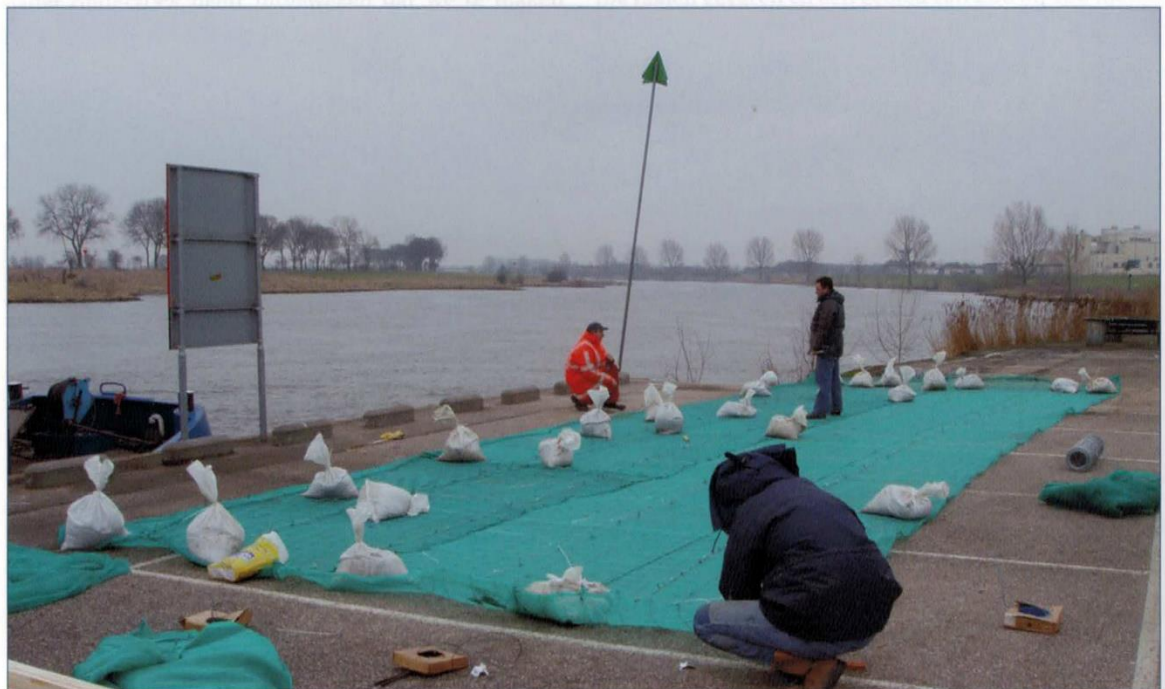
De klei bovenop het gebied 6000 is afgedekt met polypropyleen gaas en een net van staaldraad (foto: M. Manders, RACM)
