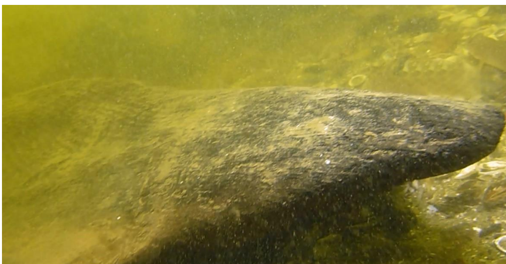
Afbeelding 10 Afgesleten uiteinde van de centrale balk.
