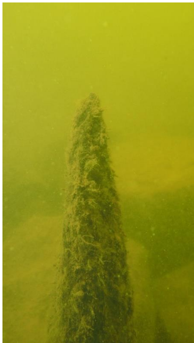
Sterk aangetaste palen.
