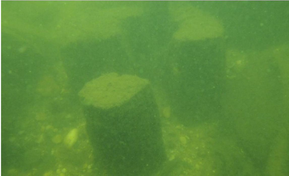
Nog goed geconserveerde paalkoppen, lang geleden afgezaagd ten behoeve van dendrodateringen.
