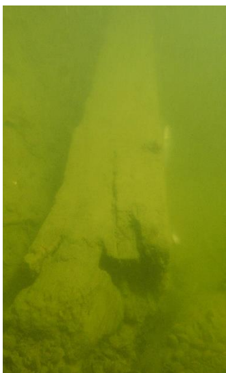
Losse palen onder de slijtrand.
