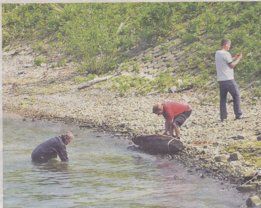
Duikers halen de houten funderingspaal naar boven.
